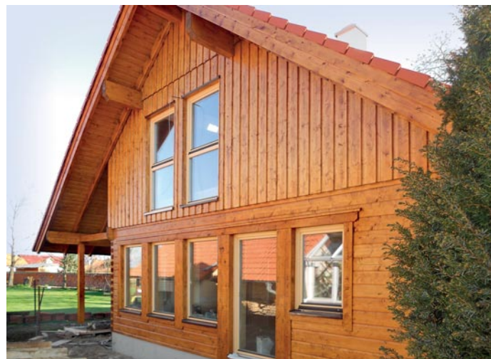
SVĚTLÁ LAZURA BUDE MÍT DLOUHOU TRVANLIVOST. DŮM JE POSTAVEN Z VYSUŠENÝCH HRANOLŮ A CHRÁNĚN OKOLNÍ ZÁSTAVBOU FOTO PAVEL EHL
