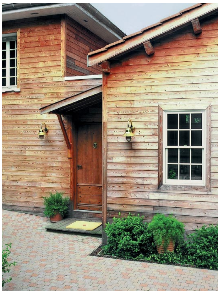
TENKOVRSVÁ LAZURA VYNIKÁ VÝBORNÝMI PENETRAČNÍMI SCHOPNOSTMI. PRONIKÁ HLUBOKO DO PÓRŮ DŘEVA, TAKŽE JE VLASTNĚ CHRÁNÍ ZE VNITŘ FOTO BONDEX
