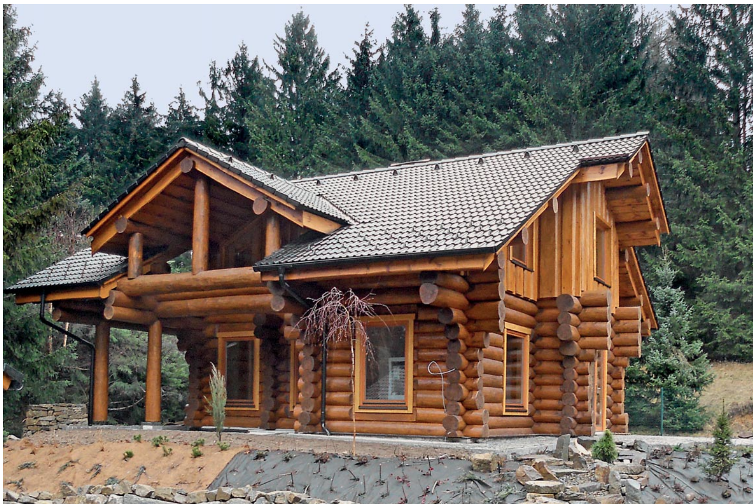
SRUB VYPADÁ DVOUBAREVNĚ, PŘESTOŽE BYL NATŘEN JEDNOU BARVOU. ROUBENÍ ZŮSTALO DLOUHO NEOŠETŘENÉ A I PO VYBROUŠENÍ DO SVĚTLÉHO ODSTÍNU A NATŘENÍ ZTMAVLO OPROTI ŠTÍTU A PODHLEDŮM, KTERÉ SE DOKONČOVALY POZDĚJI
