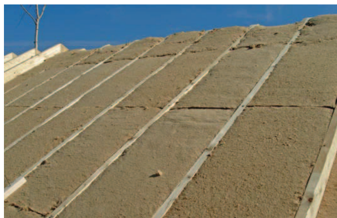
DŘEVOVLÁKNITÁ IZOLACE NA STŘEŠE
